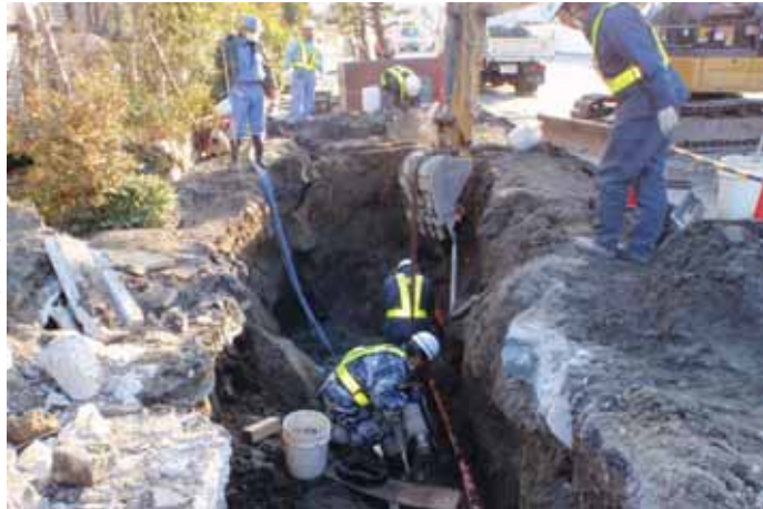
三月十八日 浦安市 神奈川県管工事業協同組合提供
